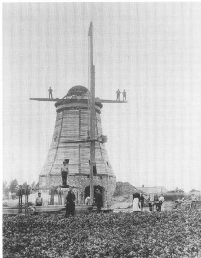
De molenaar wordt langs de roede met een kaapstander opgetakeld.
