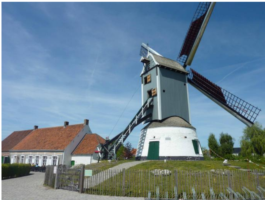
De Oostmolen in Gistel, een 'staakmolen' op torenkot', compleet ingericht als koren- en oliemolen. De stander werd doorboord om de olieslagerij door het wiekenkruis te kunnen laten aandrijven. (foto: www.vlaamsemolens.com )
