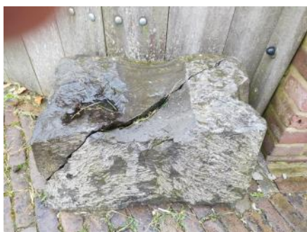
Twee gebroken halstenen: de linker in 2013 en de rechter 9 jaar later. Oorzaak: onregelmatige slijtage aan de hals van de gietijzeren as. (foto's: Geert van Stekelenburg)
