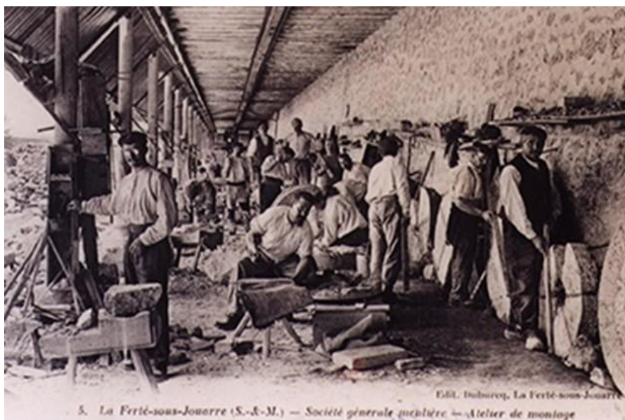
5. La Ferté-sous-Jouarre (S.-&-M.) — Société générale meulière — Atelier de montage
