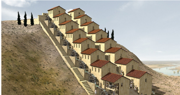
Reconstructietekening van de Romeinse watermolens bij Barbegal in Zuid-Frankrijk (afbeelding: www.historianet.nl )
