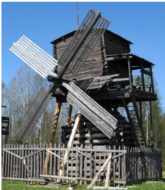
Een voor onze begrippen vrij kleine Russische standerdmolen met een as die vrijwel onderaan uit de molenkast naar buiten steekt.
