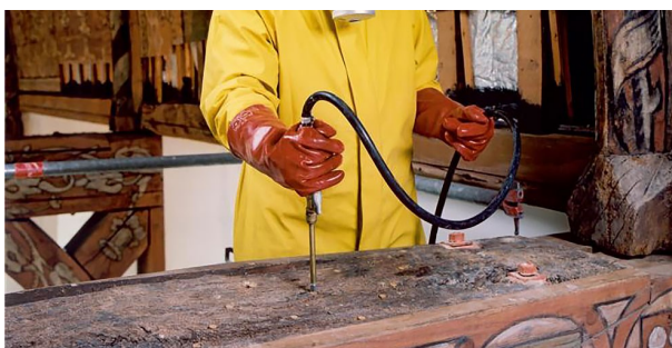
Het lage druk injectiesysteem wordt hier toegepast. (afbeelding: www.vanlierop.nl )
