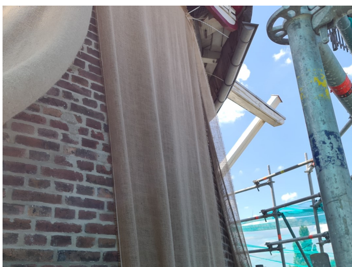
Aan de kalkspecie werd een klein deel Portland cement toegevoegd om een iets snellere uitharding te verkrijgen. Om het afbinden van de specie goed te laten verlopen werd het voegwerk regelmatig bevochtigd en met jute afgedekt. (foto Peter van Rongen)
