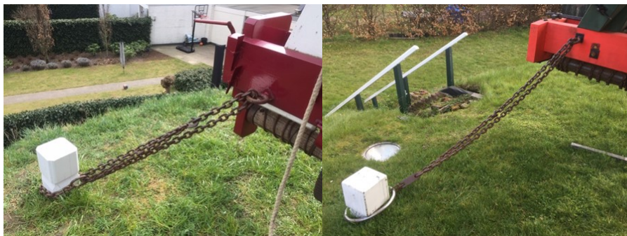
Links ligt de bezetketting als één geheel dubbel geslagen van kruibok naar kruipaal. Rechts ligt hij ook dubbel, maar is aan het eind voorzien van een ring. Zou dit problemen kunnen opleveren bij het zogenaamde 'vangen met de staart'? (foto's Jan Molenkamp)
