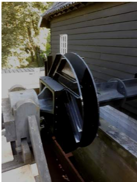
De naaf van het watterrad. (foto: Hans Kalkhoven)
