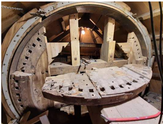
Hier wordt het oude plooistuk verwijderd, heeft zijn beste tijd gehad. (foto: Willem Boender)
